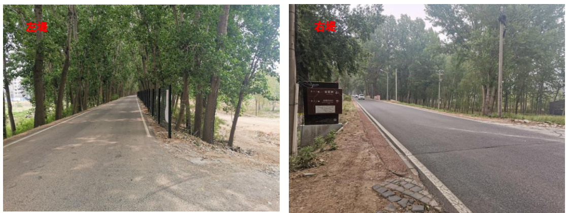
图 2-11 拟建厂通路处潮白河左右堤照片
