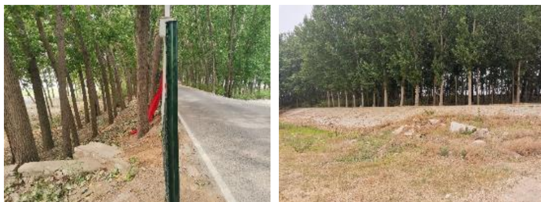
图 2-13 左岸现状堤防照片
