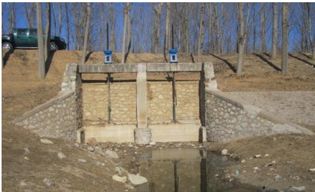
图 2-14 柳甸洼排闸照片
